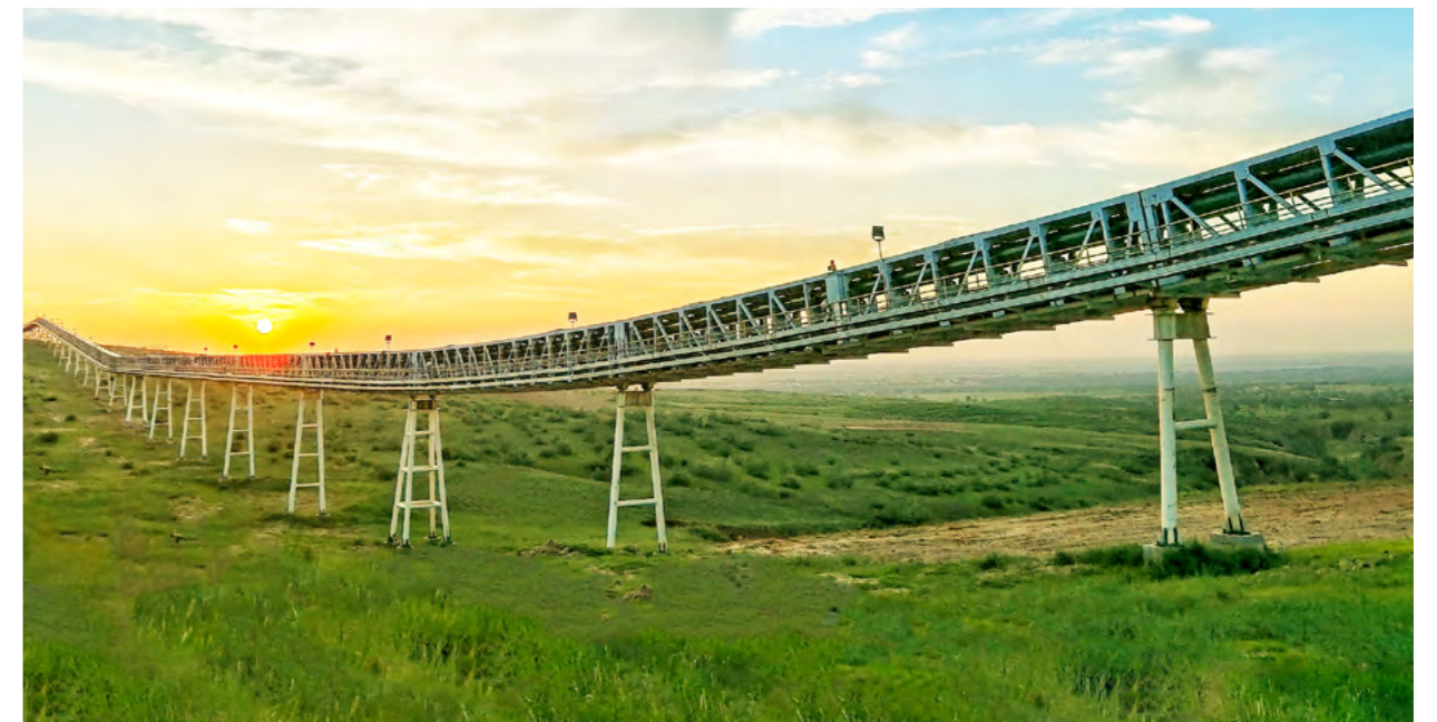
内蒙古托克托发电公司开展圈圈免沟项目利用管道式运输机将托电所产粉煤灰密闭输送至圈圈免沟小流域进行贮存和生态治理，开创了国内利用粉煤灰进行小流域综合治理的先例
