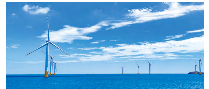
福建平潭公司长江澳海上风电项目 15 台风机顺利通过 240 小时试运
